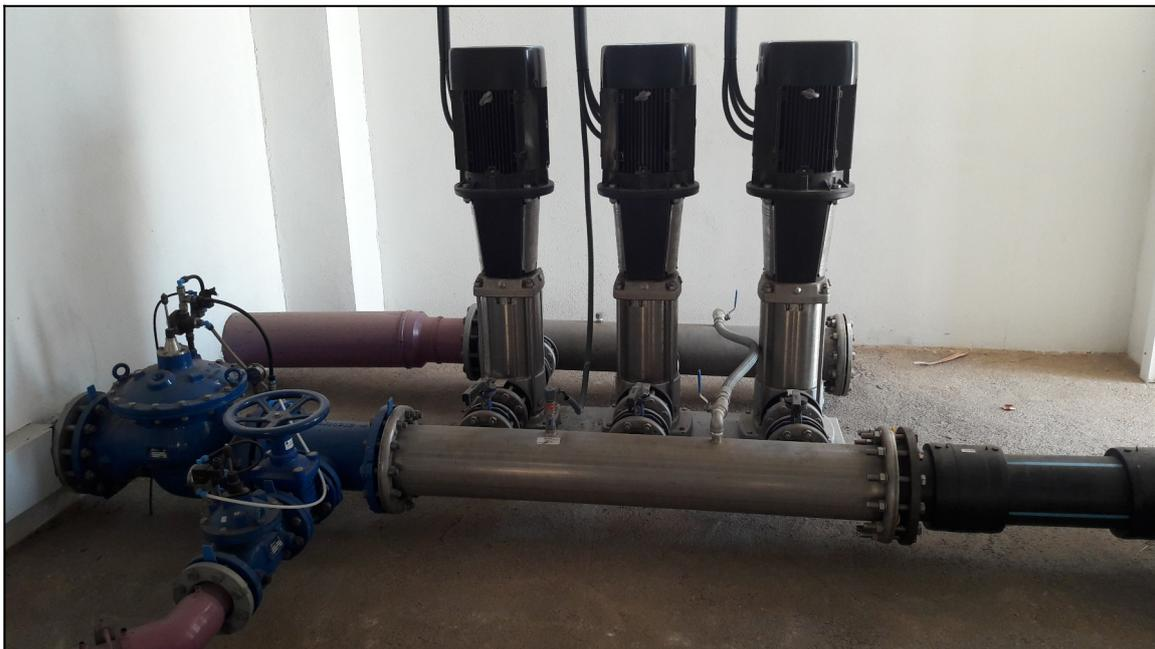
*Figura 14. Grupo de bombeo para impulsión del agua regenerada.*
