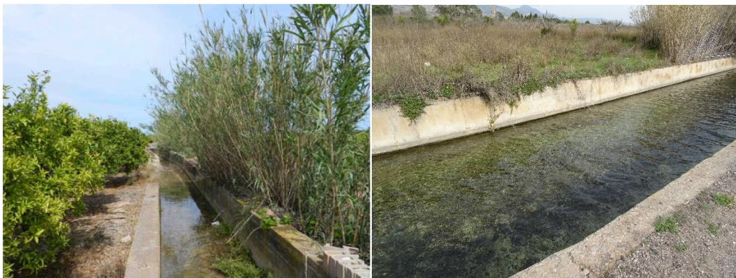
Imagen de acequia con agua limpia en circulación. Fuente: Ayto. de Castelló de la Plana
